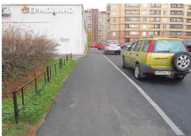
Ремонт асфальтового покрытия, Богатырский пр., 51, к. 1
