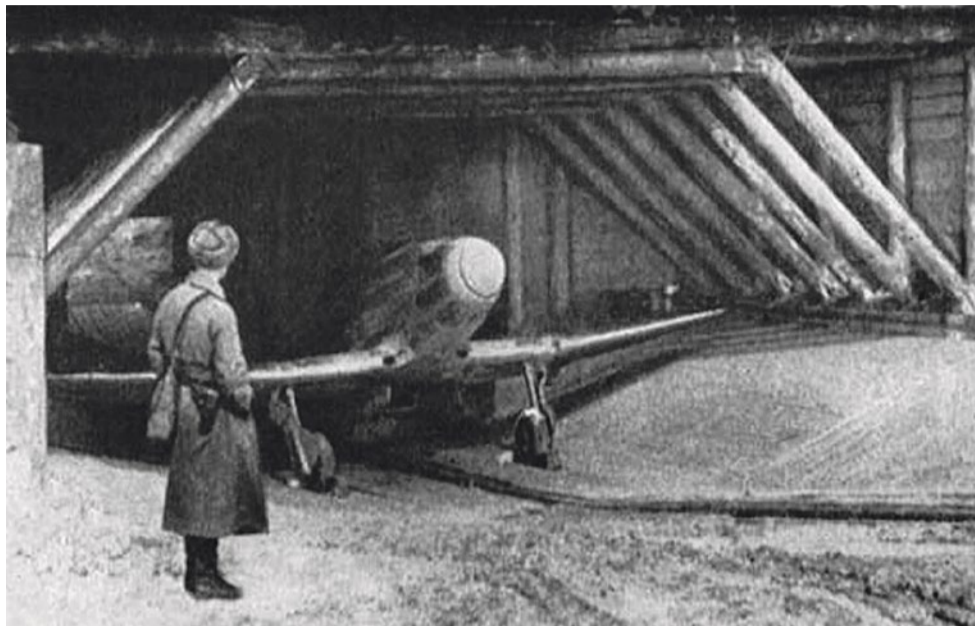
Укрытие из бревен для защиты самолетов на аэродроме, 1941 г.
